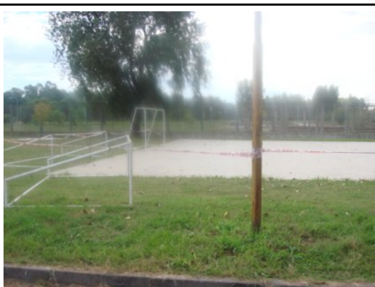
Poste de luz inhabilitado por cortocircuito
