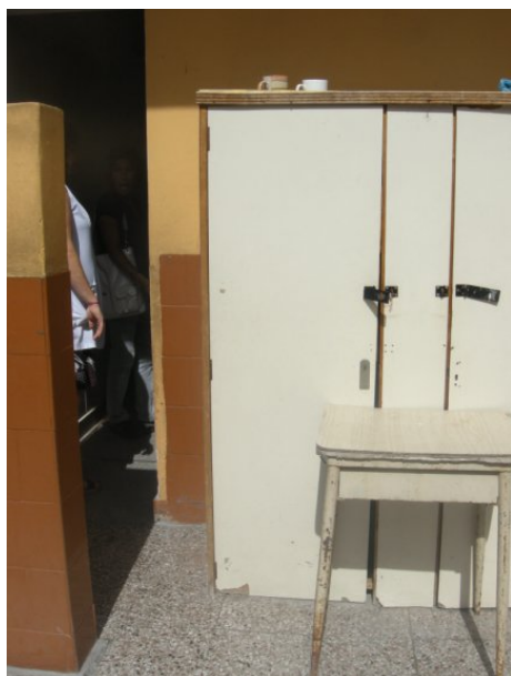
Circulaciones obstruidas con mobiliario.
